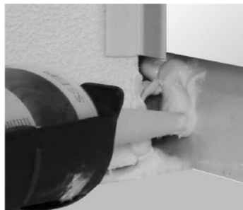
illustration 1 / poser l'élément de retour en embrasure au même nu sur l'isolation de façade
