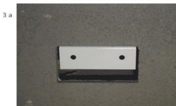
illustration 3 : fixation StoElement Fauna MS-F 20
