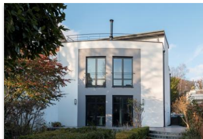
Maison de particuliers à Suresnes (92)
