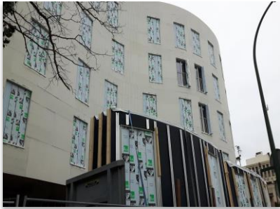
Logements sociaux avenue Fayolle à Paris 16 ème réalisés avec des façades à ossature bois
