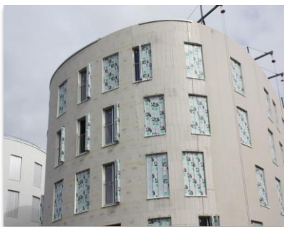
Le calepinage des plaques à enduire StoVentec, étudié en fonction de l'emplacement des 600 fenêtres, intègre 31 rayons de courbure différents.
