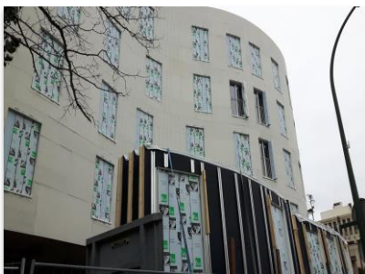
L'industrialisation des murs cintrés en ossature bois a été poussée au maximum en intégrant en usine les 600 menuiseries, leurs volets et leurs garde-corps.
