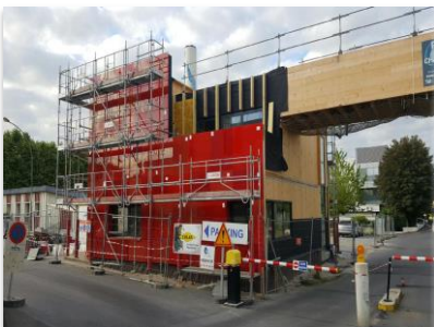
Poste de sécurité incendie et anti-malveillance du CHI André Grégoire, à Montreuil (93), construit avec une structure CLT
