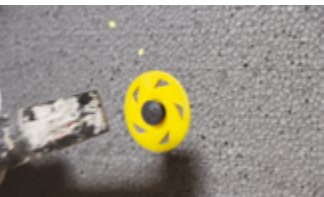
120 mm en polystyrène gris : Sto-Panneau Isolant Top31 (R = 3.7).
