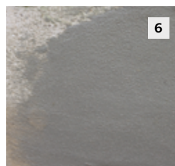
6 Laisser sécher entre 2 et 4 heures avant l'étape suivante.
