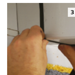
3 Coller la bande d'étanchéité autour du chevron.
