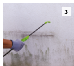
3 Pulvériser le décontaminant à refus sur la façade.
