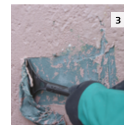
3 Éliminer le revêtement avec un scrapper ou un riflard.
