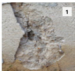
1 Éclat de maçonnerie en façade.
