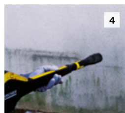
4 Laisser agir 6h à 24h et rincer à l'eau sous pression.
