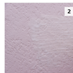
2 Laisser agir le décapant jusqu'au cloquage du revêtement.
