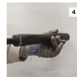
4 Laver à l'eau froide avec un nettoyeur haute pression puis laisser sécher avant mise en peinture.
