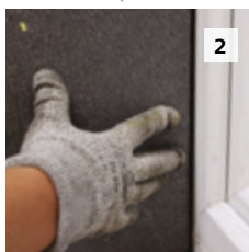
2. Pose de l'isolant en tableaux de fenêtres/portes.
