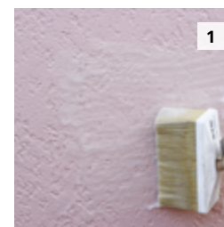
1 Appliquer grassement le décapant avec un rouleau ou une brosse carrée.
