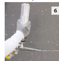
6. Traitement des joints de plaques si nécessaire.
