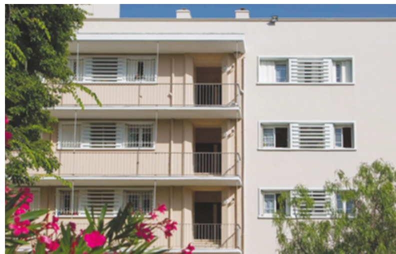
Résidence du Trioulet (13) Maître d'ouvrage : 13 Habitat Maître d'œuvre : Laurent Leccia Solution Sto : StoCrete TK, StoCrete SM, StoPlex W, StoLevell Réno, StoColor Solical © Matthieu Colin
