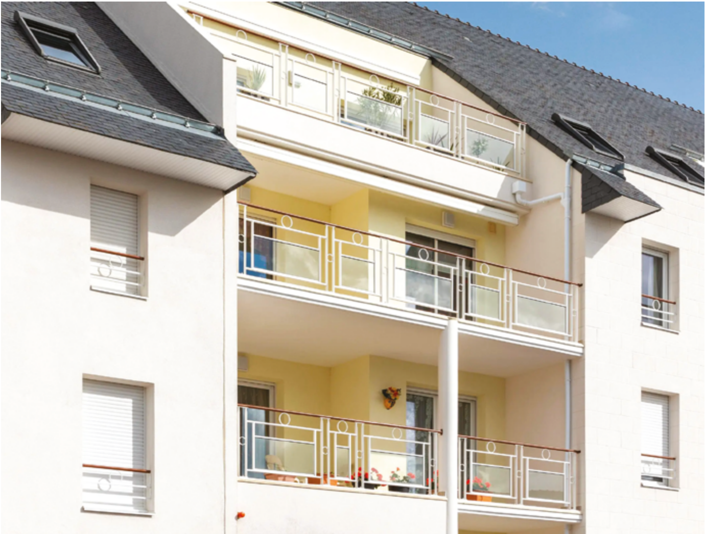
Résidence Nautilus (44) Maîtrise d'ouvrage : copropriétaires représentés par le Conseil syndical Maître d'œuvre : Batimex Solutions Sto : impression StoPrim BL, couche intermédiaire Irtop SC, revêtement d'imperméabilité taloché Irtop S K 1,5, peinture Irtop S Velouté Mat pour la jonction entre l'étanchéité horizontale et verticale ©Manuel Panaget
