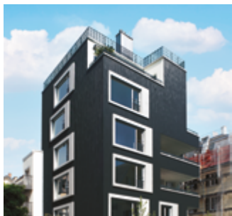
Maison de ville Zurlindenstrasse, Zurich, CH
