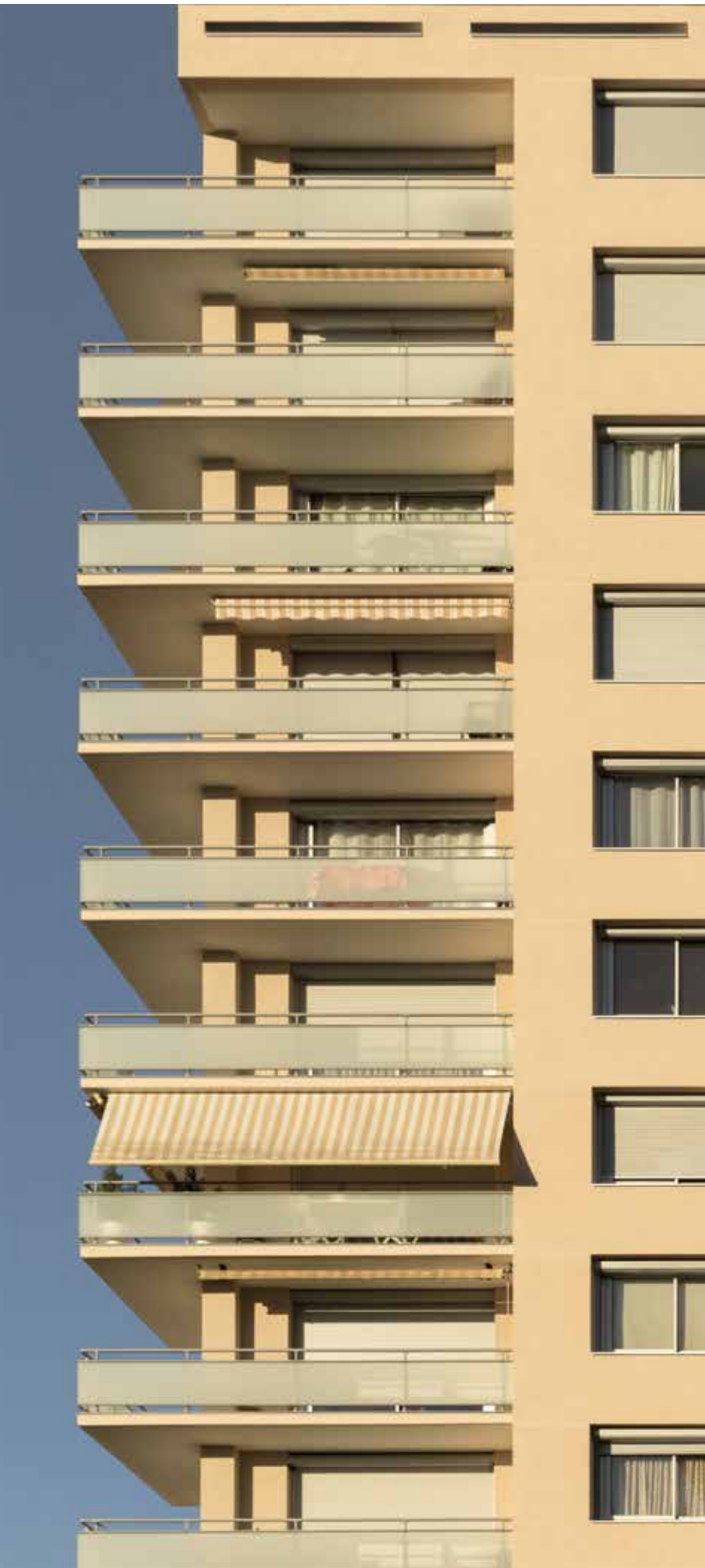
Résidences Fleuries, Bourg-en-Bresse (01) Maître d'ouvrage : Syndicat des copropriétaires de la tour 17 « Les Résidences Fleuries », syndic Cabinet BOISSON Maître d'œuvre : Bemotech Solutions : Systèmes d'ITE StoTherm Minéral et StoTherm Résol, enduit de finition siloxané StoSilco K, aspect taloché. ©Aurélien Aumont
