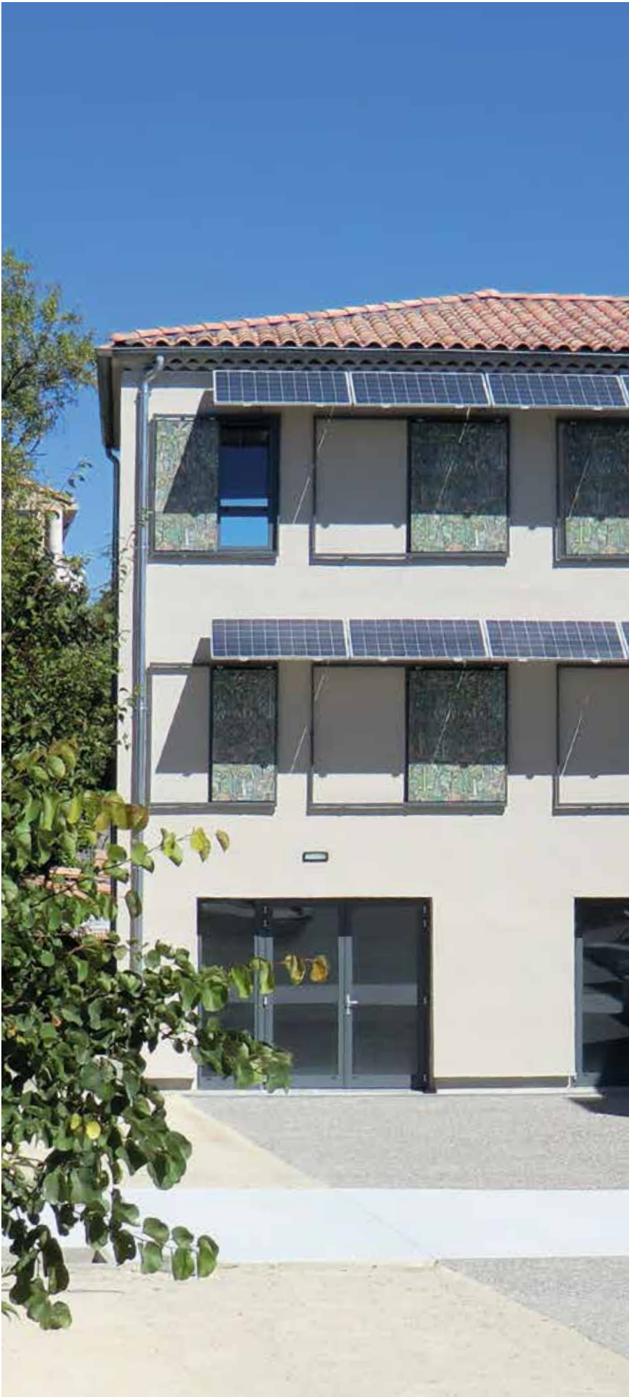
Maison des métiers du livre, Folcaquier (04) Maître d’œuvre : R+4 Architectes Solutions : StoTherm Wood isolant fibre de bois ©Sto
