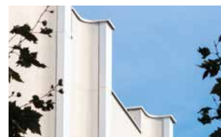
Cintrage de panneaux isolants
