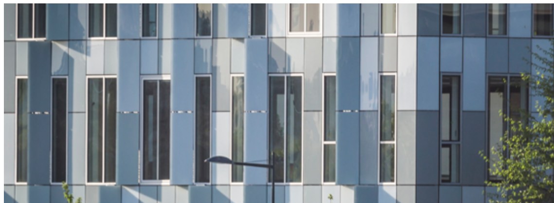
Bureaux à énergie positive Green Office® en Seine, Meudon, FR Maître d'ouvrage : Bouygues Immobilier, Issy-les-Moulineaux Architecte : Carta, Reichen et Robert, Paris Solutions : StoVentec Glass A Crédit photo : Mateya Lux, FR
