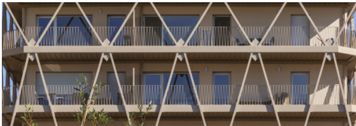
Résidence IKKSO, Bordeaux, FR Maître d'ouvrage : Bouygues Immobilier Architecte : CoBe Architecture et Paysage Solutions : StoVentec R Enduits, avec finition grain K 1,5 Crédit photo : Manuel Panaget, FR
