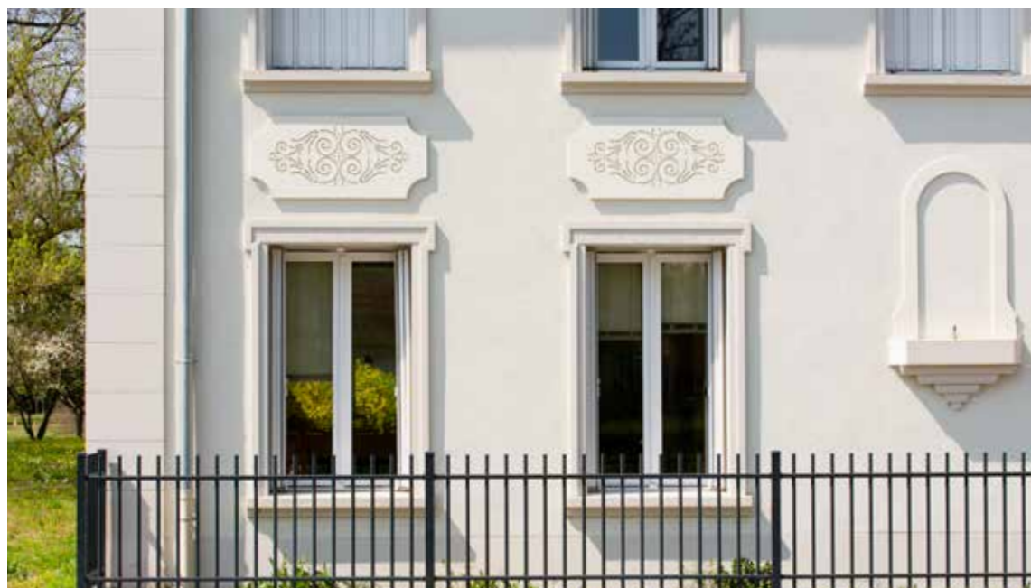
Habitat social, Strasbourg, FR Architecte : Patrick Schweitzer et Associés Maître d'ouvrage : Domial Solutions : système d'ITE StoTherm Vario, finition Stolit K1,5. Encadrements et appuis de fenêtre StoDeco sur mesure. Photo : Siméon Levaillant
