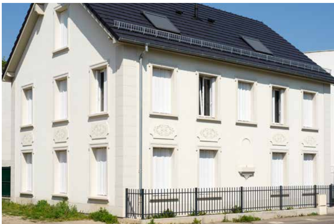
Habitat social, Strasbourg, FR Architecte : Patrick Schweitzer et Associés Maître d'ouvrage : Domial Solutions : système StoTherm Vario, finition Stolit K1,5. Encadrements et appuis de fenêtre sur mesure. Photo : Siméon Levallant
