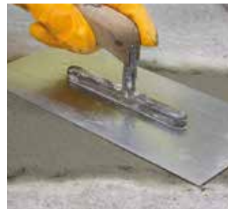
Exemple de réparation d'un éclat de béton
