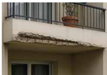
Éclats de béton dus à l'oxydation des armatures métalliques
