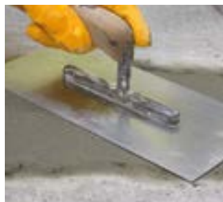
Exemple de réparation d'un éclat de béton
